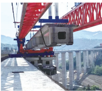
椴木松沟8号桥右幅贯通 白山市交通运输局供图
