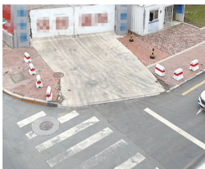
卫宇街上一工地阻车桩占据公共空间
