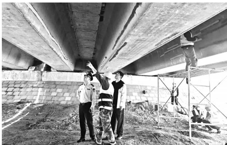
巡查排查桥隧边坡 省交通执法局供图
