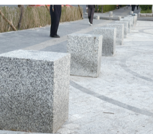
南湖新村中街阻车桩上没有反光条
