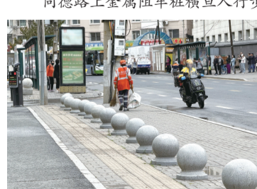
民安路公交站旁阻车石墩设在人行道上
