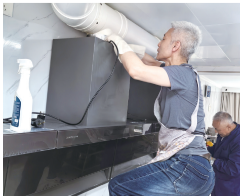
团队里的义工换了新的厨房管道
