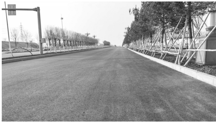
即将通车 城市晚报全媒体记者 陆续 摄
