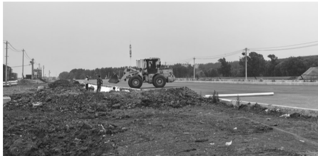
有挖掘机还在施工 城市晚报全媒体记者 吕闯 摄
