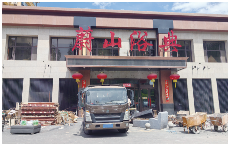
正在进行施工 城市晚报全媒体记者 陆续 摄
