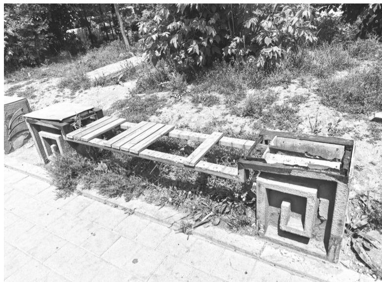
此处座椅损坏较严重 本组图片 城市晚报全媒体记者 吕闯 摄
