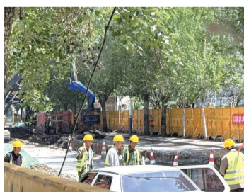
施工人员正在忙碌中
