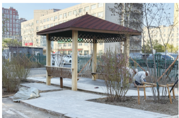
正在建设的凉亭
