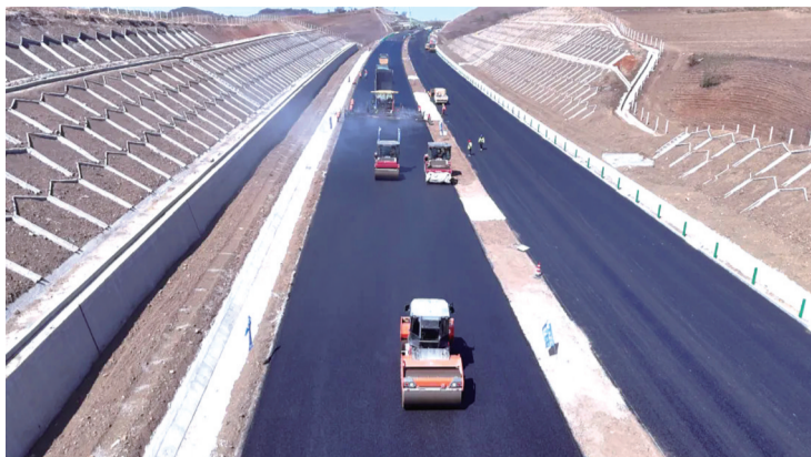
全力冲刺项目建设节点目标 省高速公路集团供图
