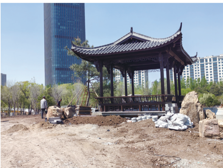
核心建筑施工正有序推进 城市晚报全媒体记者 陆续 摄
