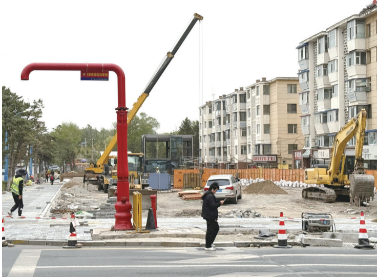
绿化和硬化施工进行中 本组图片 城市晚报全媒体记者 刘佳雪 摄
