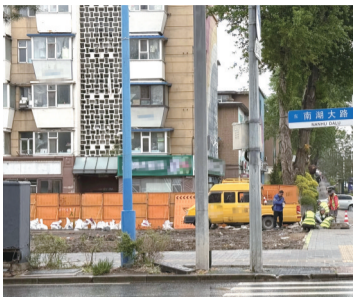
施工人员正在现场作业
