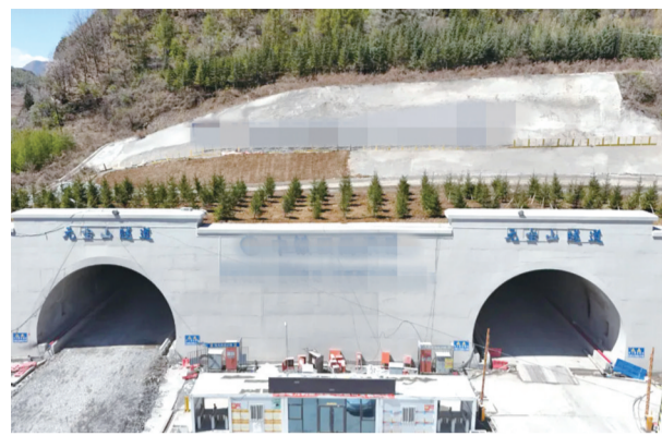
元宝山隧道实现双洞贯通 吉高集团供图
