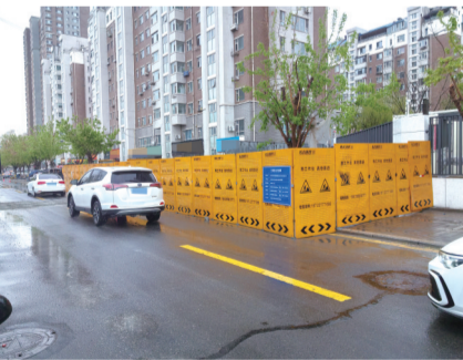
竖立围挡进行施工
