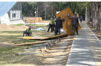
施工人员竖立施工围挡
