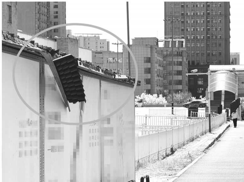
围挡装饰脱落倾斜 本组图片 城市晚报全媒体记者 刘佳雪 摄
