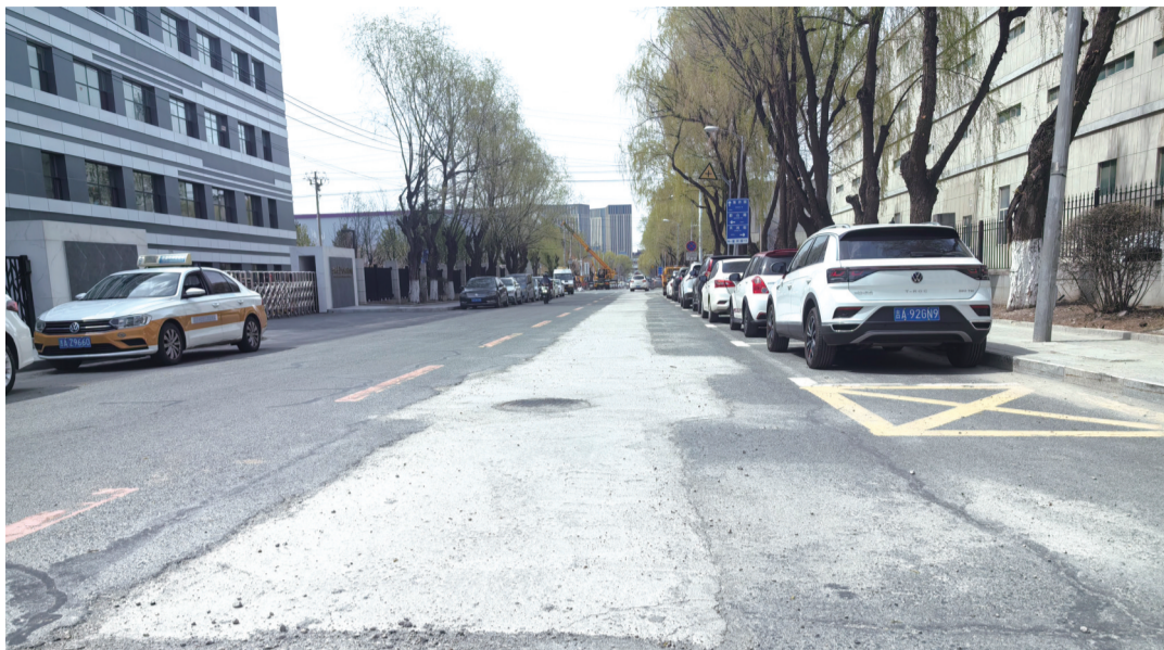
路段已全部铺设平整 城市晚报全媒体记者 陆续 摄
