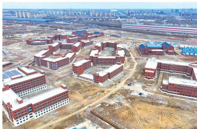
18栋主要建筑已经完工 长春新区供图
