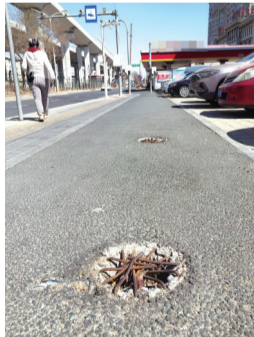
此前路上的圆洞裸露钢筋
