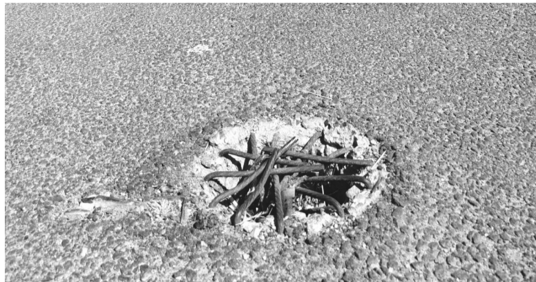
钢筋突出地面高度在3厘米至5厘米之间 城市晚报全媒体记者 陆续 摄
