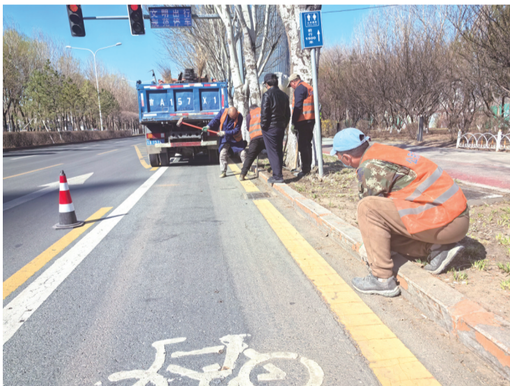
施工人员正在作业 城市晚报全媒体记者 陆续 摄
