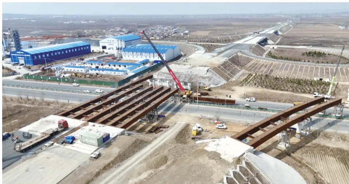
大型吊装设备精准作业 省交通宣教中心供图
