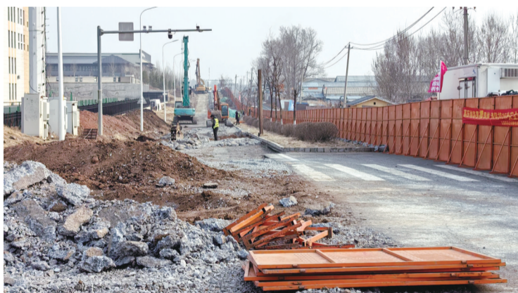
金河街施工现场 城市晚报全媒体记者 陆续 摄
