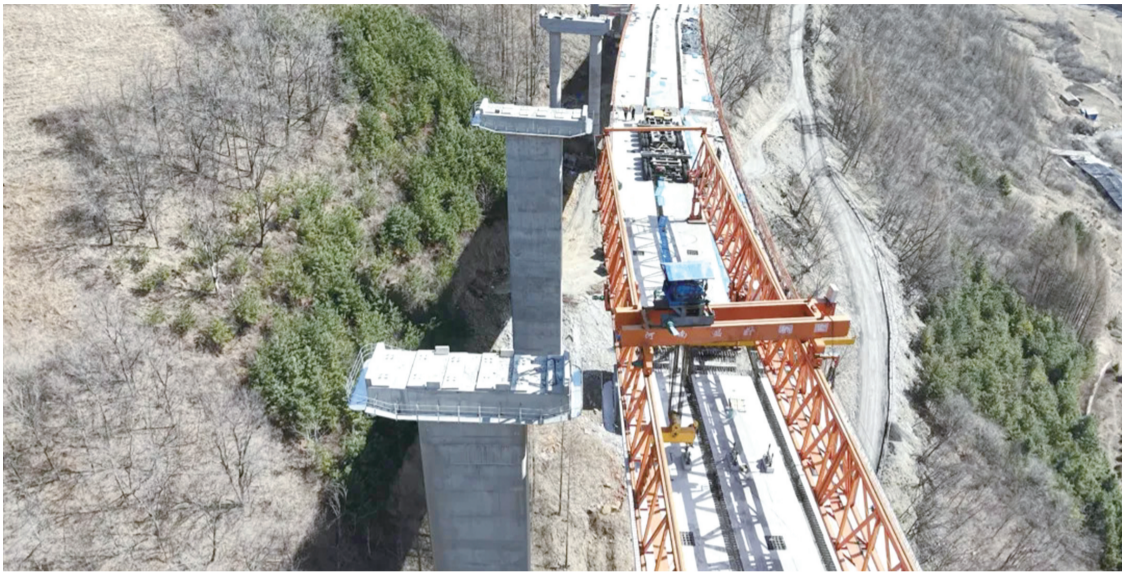
加快推进高速公路项目建设 省交通运输厅供图
