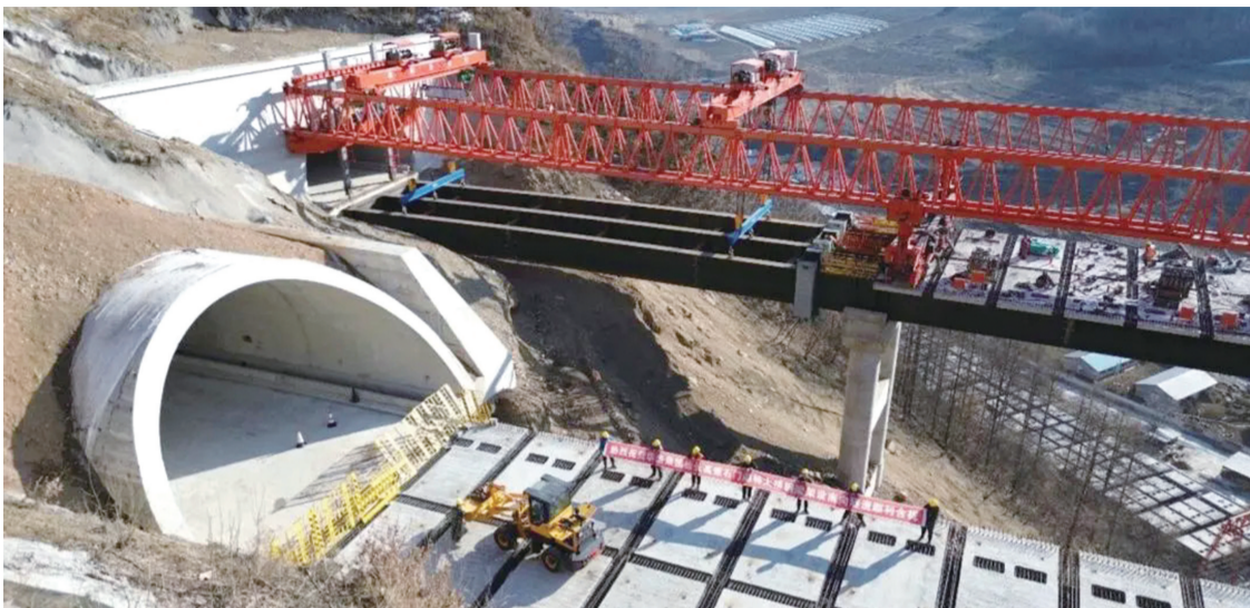
钢梁架设与南向隧道顺利合龙 白山市交通运输局供图
