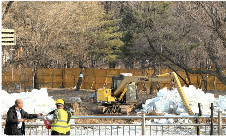
大型机械作业中 城市晚报全媒体记者 刘佳雪 摄
