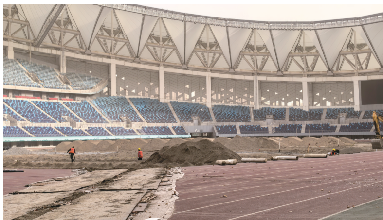
工人们正在忙碌 城市晚报全媒体记者 吕闯 摄
