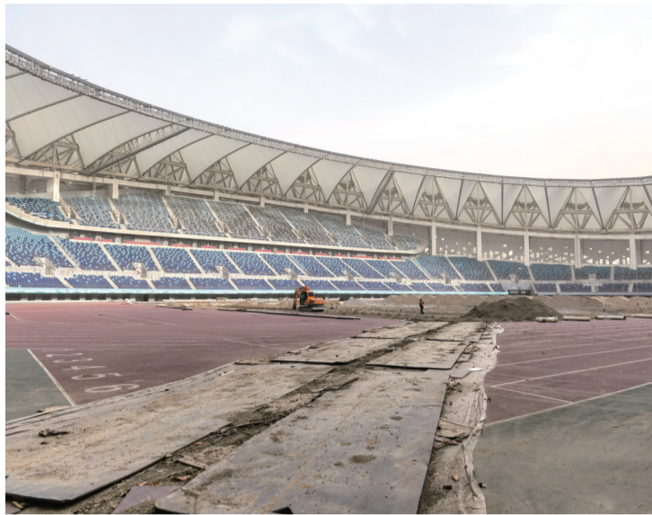
现场已进入全面施工阶段 城市晚报全媒体记者 吕闯 摄
