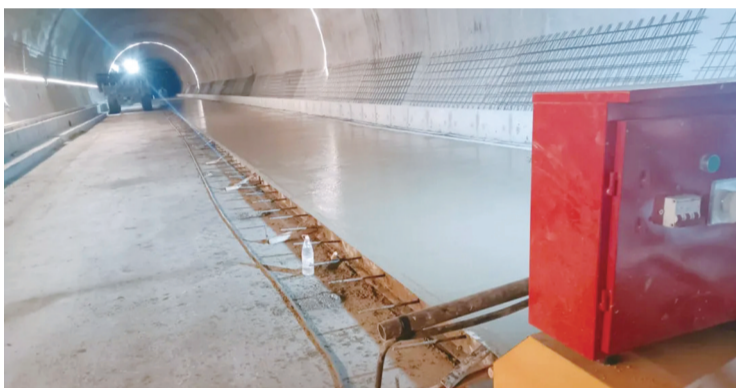
混凝土路面面层首件工程顺利完工 吉高集团供图
