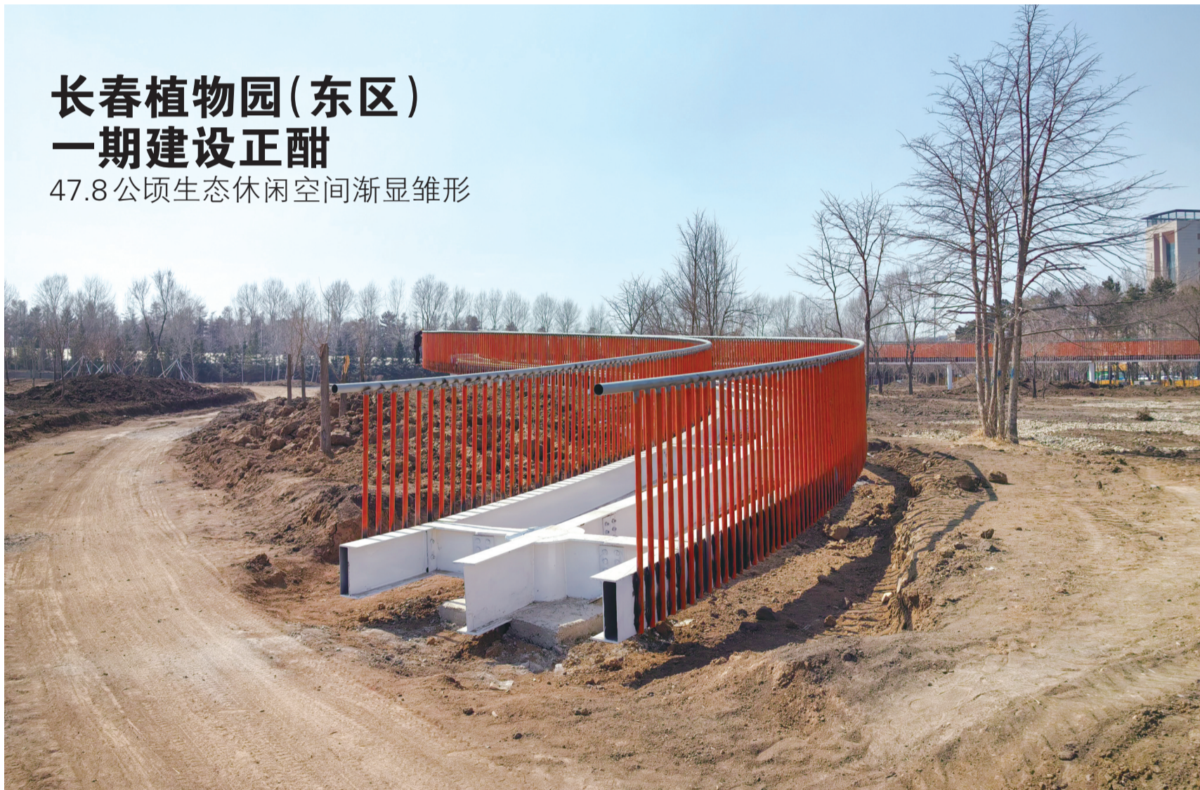
人行栈道主体基本完成 城市晚报全媒体记者 陆续 摄
