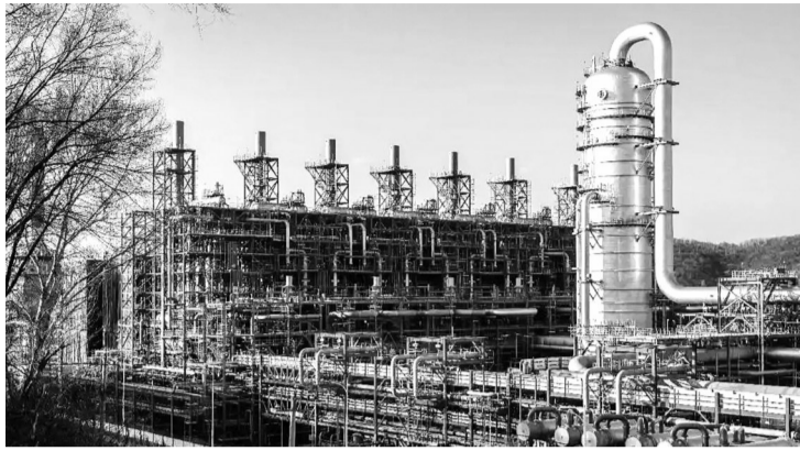
中石油吉林石化公司年产120万吨乙烯项目建设现场。新华社记者 李典 摄
