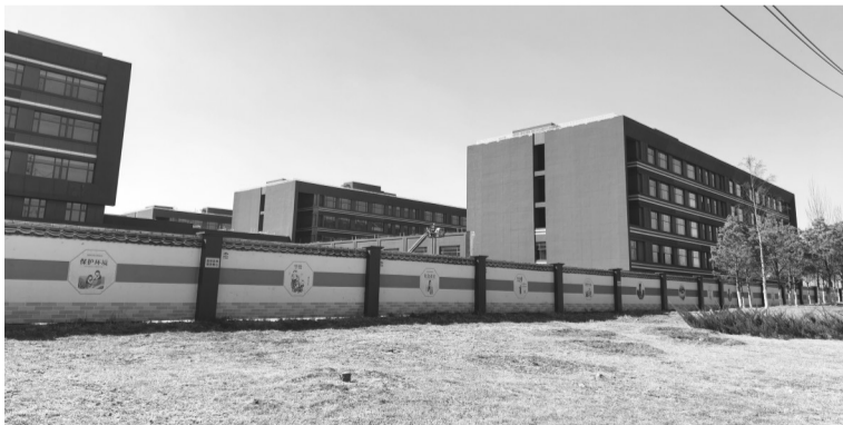
项目施工中 城市晚报全媒体记者 吕闯 摄
