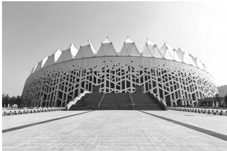
奥体公园体育场 本组图片 城市晚报全媒体记者 吕闯 摄
