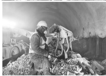
隧道施工现场
