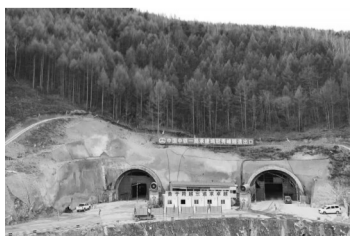
双洞全部贯通 中铁一局集团第二工程有限公司供图
