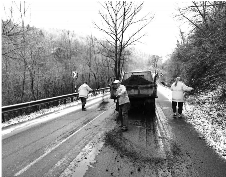
通化市公路处撒布防滑料 公路管养部门供图
