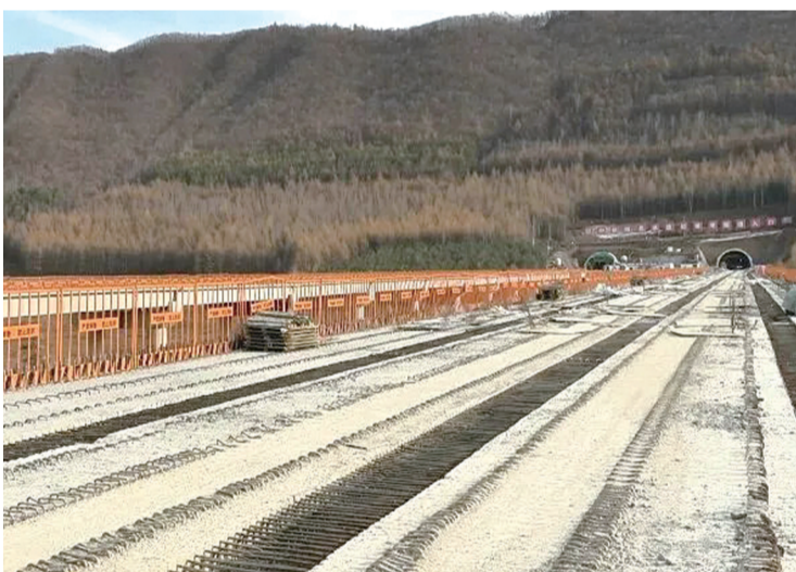
推进主体工程建设 本组图片 白山市交通运输局供图
