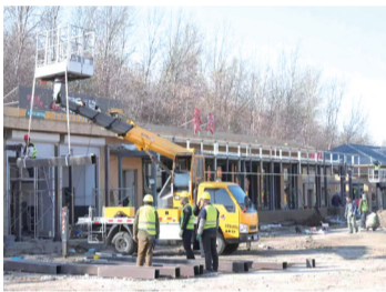
现场施工正在推进中
