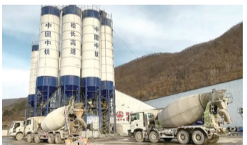
06工区施工现场
