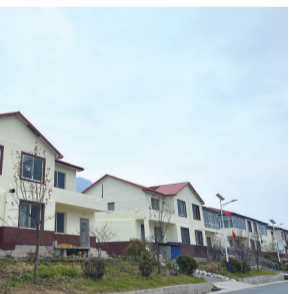
房屋换上“新装” 社区供图
