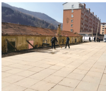
拆除后 社区供图
