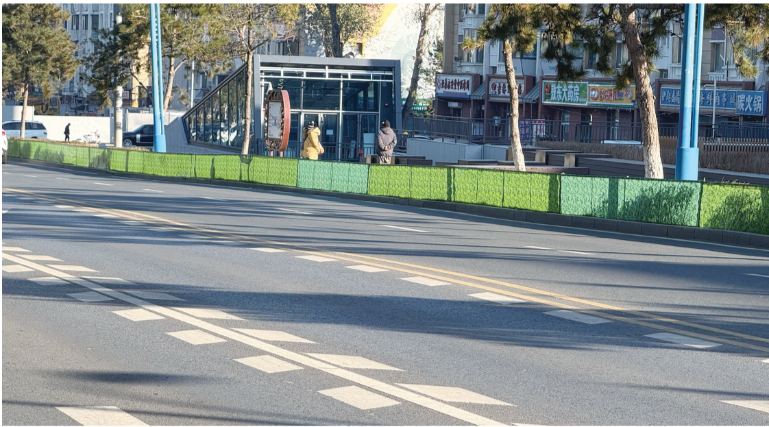
挡雪板防风防寒防融雪剂 本组图片 城市晚报全媒体记者 刘佳雪 摄
