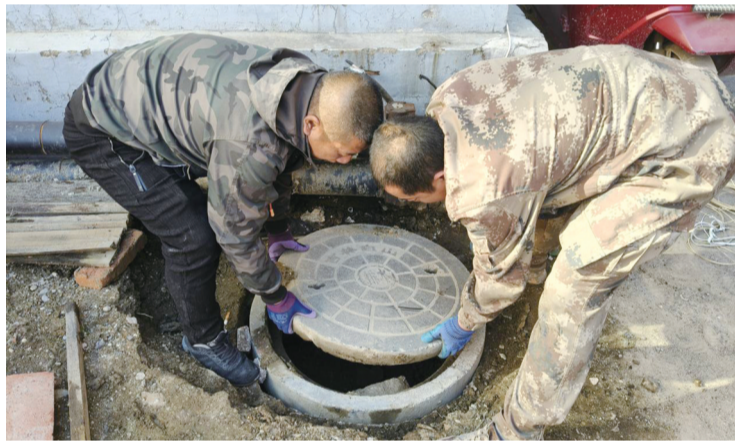
修复更换问题井盖 社区供图
