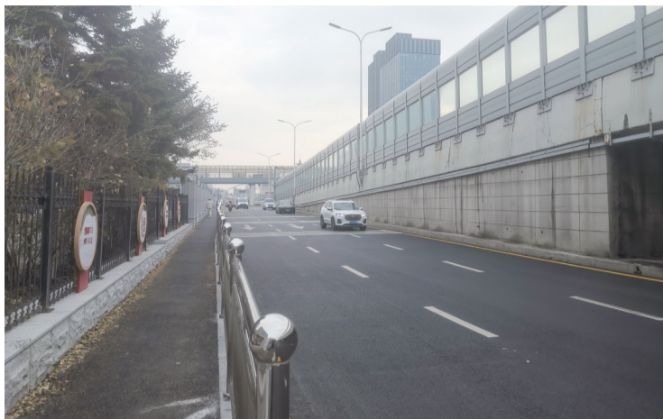
此处道路进行拓宽升级改造 城市晚报全媒体记者 吕闯 摄
