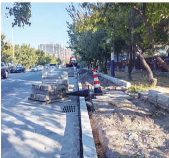
施工改造现场
