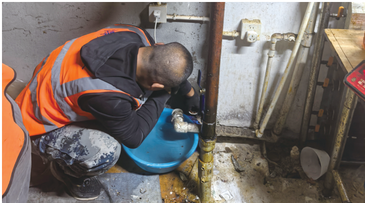
工人上门维修 社区供图
