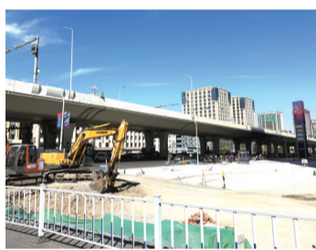
施工场地完成“退围还路”
