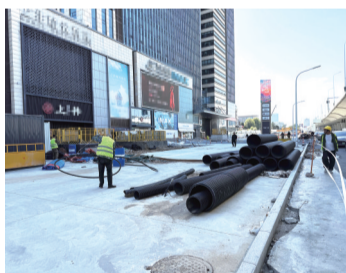
施工人员正在忙碌
