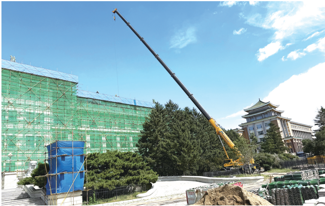
大型机械正在施工作业 本组图片 城市晚报全媒体记者 刘佳雪 摄
