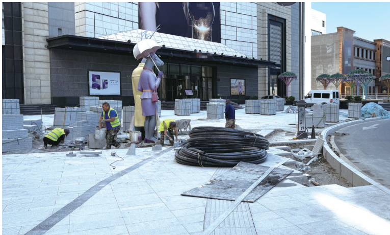
施工人员忙碌中 城市晚报全媒体记者 刘佳雪 摄
