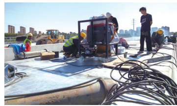
工人正在加班加点施工 城市晚报全媒体记者 陆续 摄
