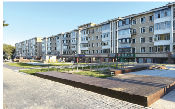
还建施工带给居民新期待
