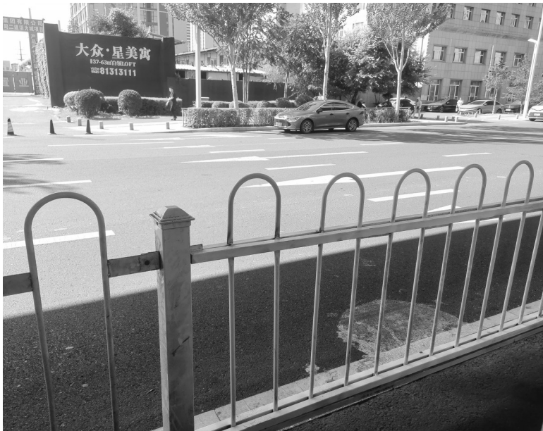
护栏已经修复 本组图片 城市晚报全媒体记者 吕闯 摄
