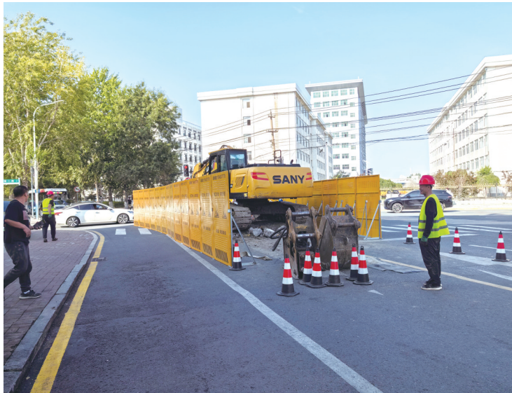
现场正在紧张有序地进行作业 城市晚报全媒体记者 陆续 摄
