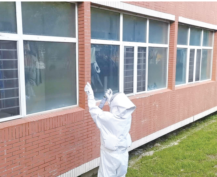
消防员处置马蜂窝隐患 消防供图
