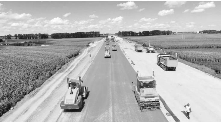
路面施工中 省交通运输厅供图 项目相关负责人表示,试验段的顺利摊铺,为后续路面施工积累了重要数据,奠定了坚实技术基础。下一步,指挥部将组织施工、监理单位总
