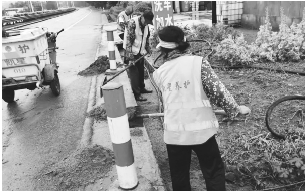
四平养护人员清理边沟淤泥 公路管养单位供图
