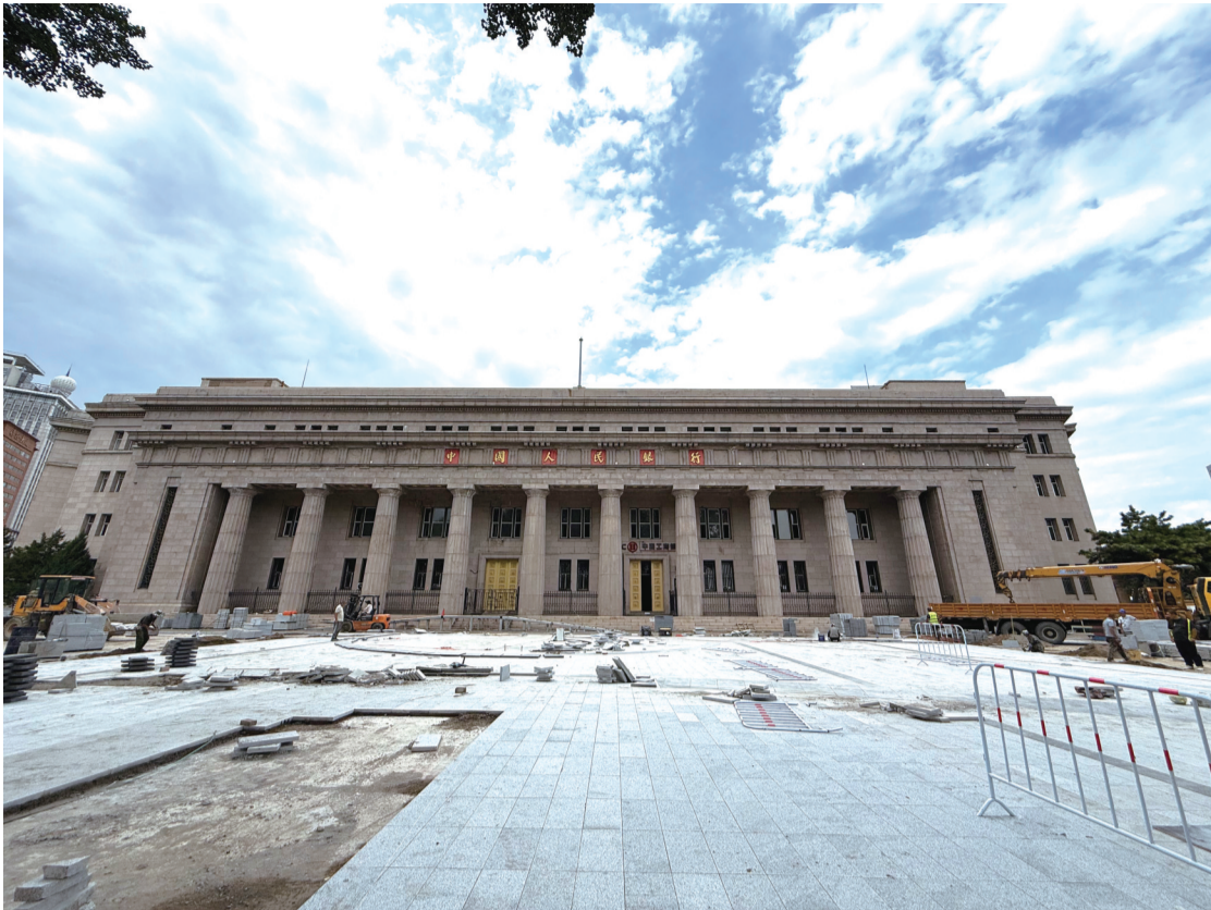
院落施工 本组图片 城市晚报全媒体记者 刘佳雪 摄
