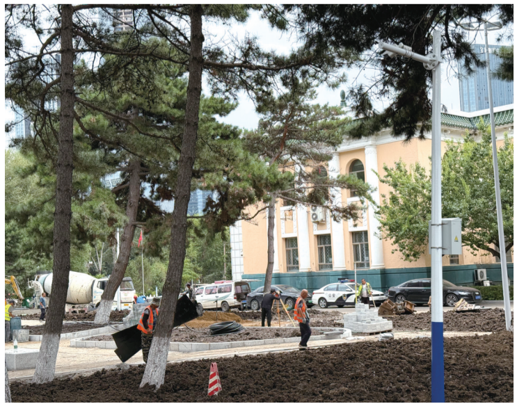
园林绿化施工
