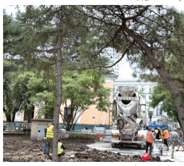
院落园路施工
