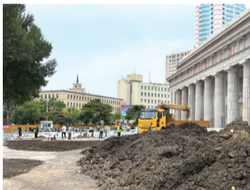
现场有人员和机械施工
